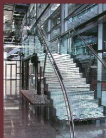
ESCALERA BARANDILLA VIDRIO Y PASAMANOS ACERO INOX.
