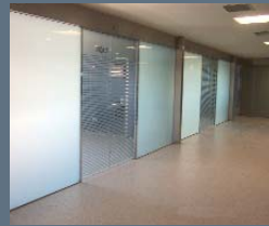
FRENTES VIDRIADOS BOX U.C.I.
