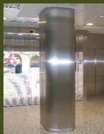
FORRADO DE PILARES
