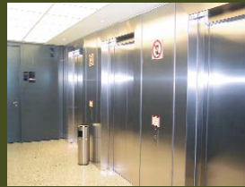
FRENTE ASCENSORES ACERO INOXIDABLE
